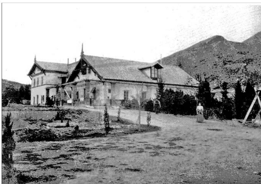
The director's and engineer's villas. Un Siglo de Historia Minera Bolea.
