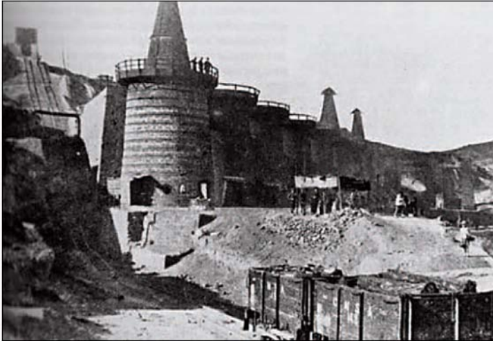
Above, working ovens. (taken from La Minería del Hierro Contemporánea en Almería. Miguel Á Perceval Verde).
